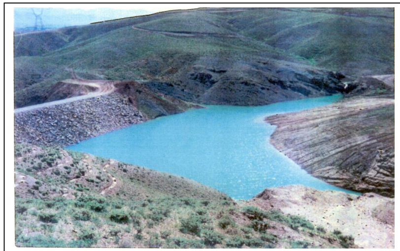
تصویر 1 - نمایی از سد خاکی سلمانلو واقع در جنوب شهر زنجان (مدیریت آبخیزداری زنجان، 1381).
